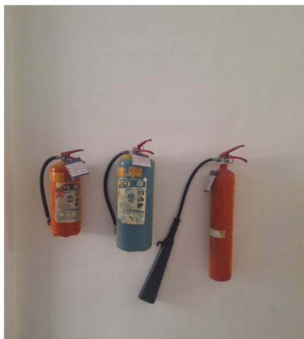
نصب و شارژ منظم کپسول های اطفاء حریق در فضاهای اداری
