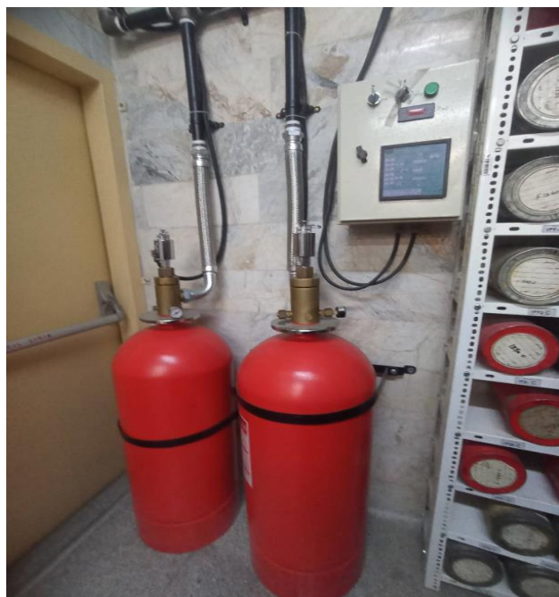
وجود کپسول اطفاء حریق در آرشيو
